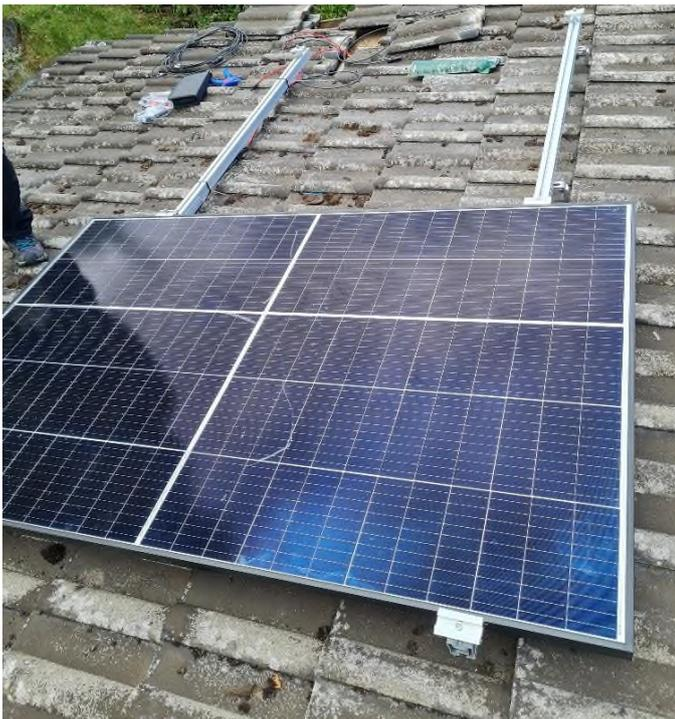
Schritt 6: Montage der Module mit den entsprechenden End- und Mittel-Klemmen
