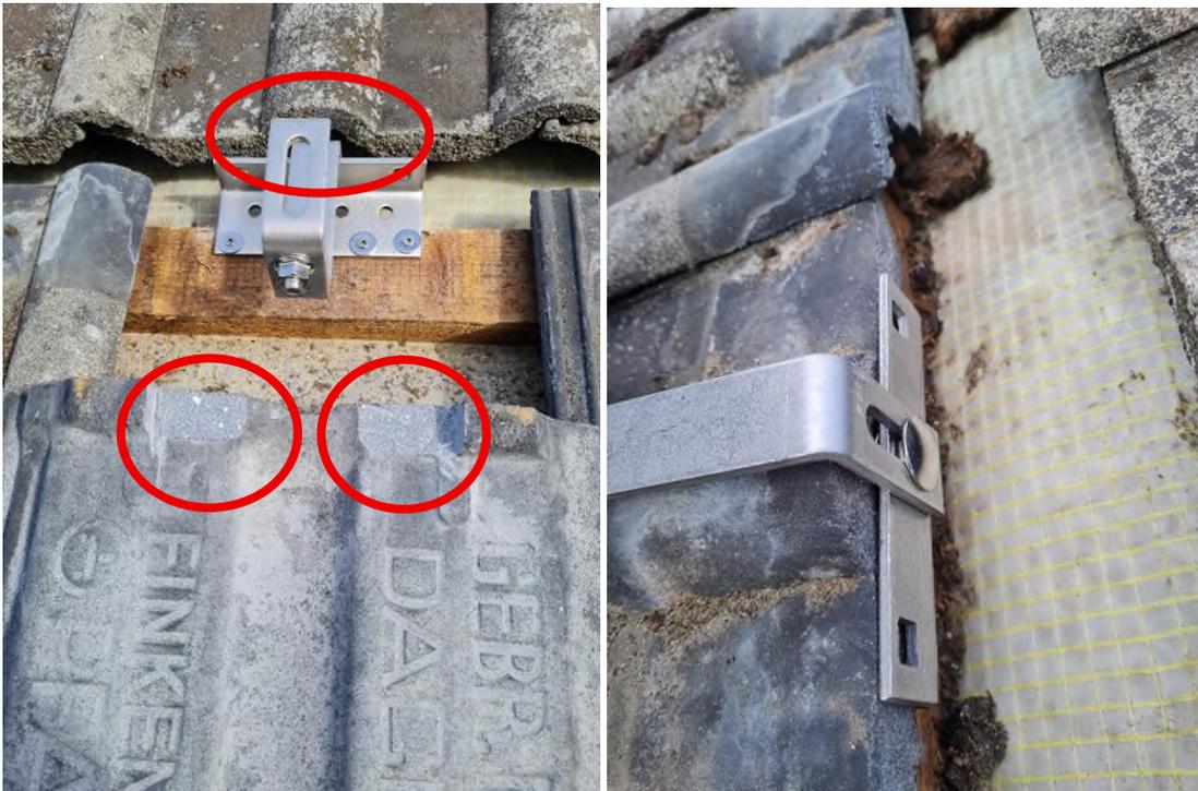
Schritt 3: Bearbeiten der Dachziegel mit Flex (unten, ggf auch oben) um die Ziegel nach der Montage der Dachhaken wieder satt aufliegen zu haben
