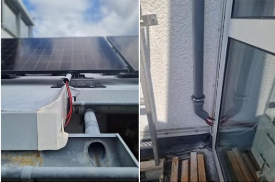
Schritt 9: Montage der Stecker und geeignete Durchführung für die 8 DC Kabel erstellen und DC Kabel vor Scheuerstellen sichern
