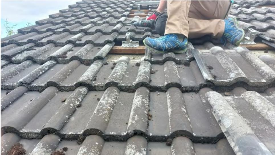
Schritt 5: Montage der Schienen mit entsprechenden Verbindern und Hammerkopfschrauben/ Zahnmuttern an den Dachhaken
