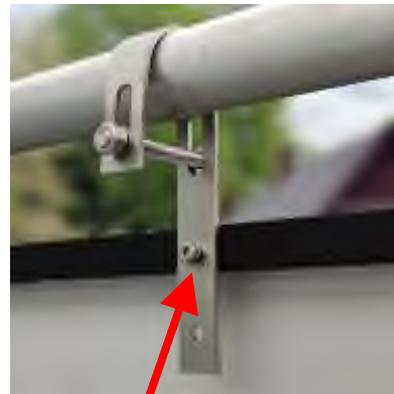
8 mm-Bohrung im Modulrahmen
