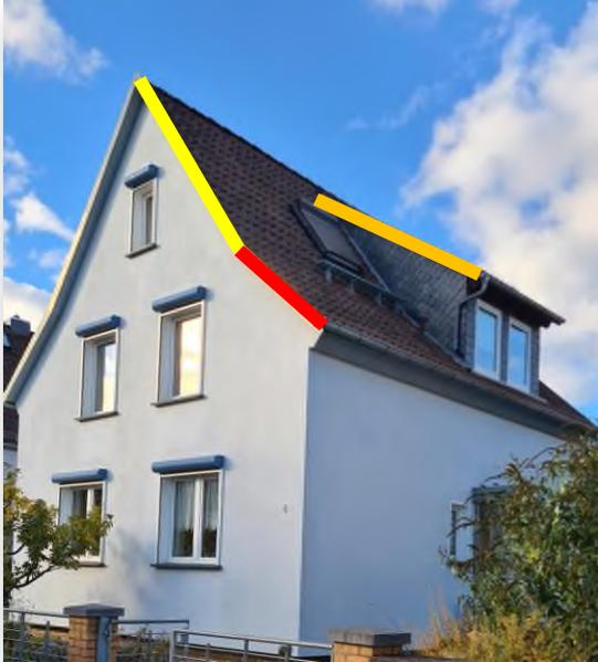
Kleine einzelne Dachflächen mit verschiedenen Neigungen und Ausrichtungen können mit String- WR nur sehr ineffizient ausgestattet werden.
